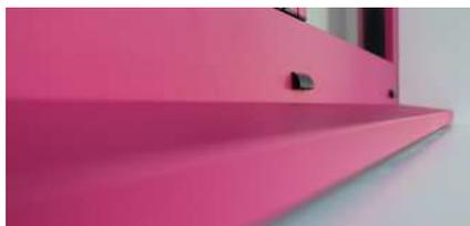
Pour apporter les mêmes garanties que le PVC blanc, les profilés plaxés et laqués sont sous avis technique du CSTB et reçoivent des renforts métalliques. Le renforcement des profils est le garant de la tenue et de la stabilité des couleurs, surtout lorsqu'elles sont foncées.
